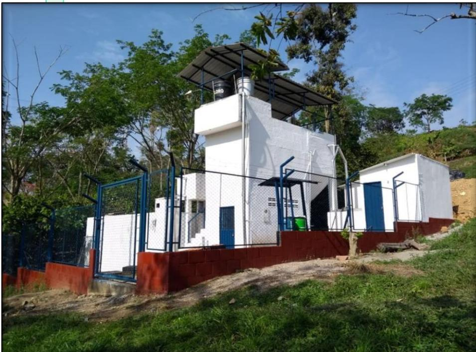
El tanque de almacenamiento es semienterrado construido en concreto reforzado con dimensiones de 8m x 8m x 4m y con una **capacidad de almacenamiento de 256 m<sup>3</sup>**.
