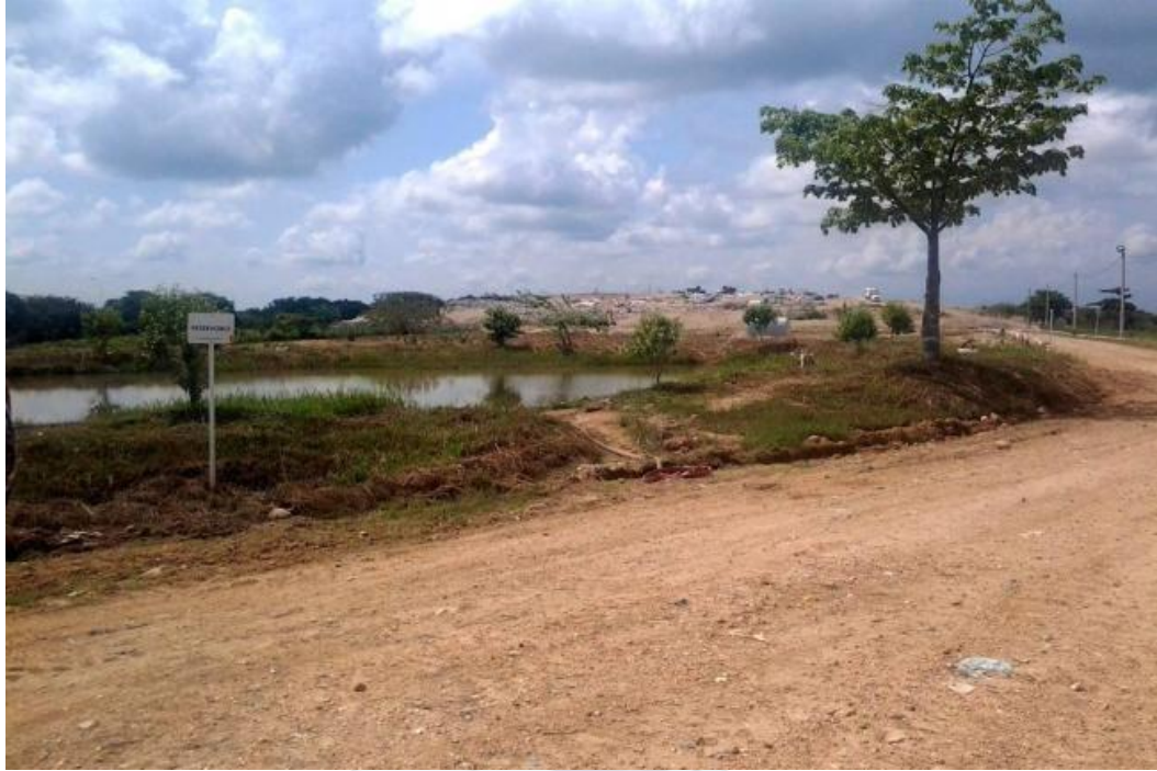
Fotografía 3. Relleno Sanitario Las Bateas
